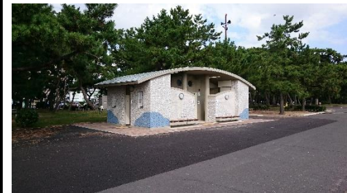
⑧公衆トイレ
