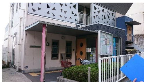
⑬北須磨地域福祉センター内トイレ
