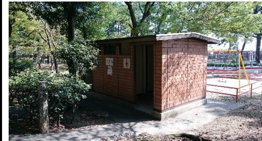
④公衆トイレ
